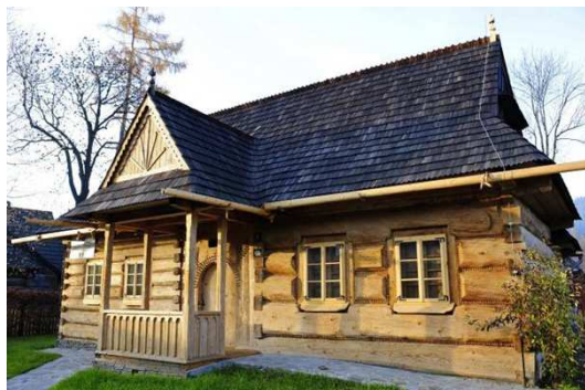
Chałupa Gąsieniców-Sobczaków po remoncie
