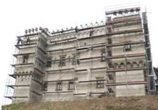
Kasztel podczas remontu
