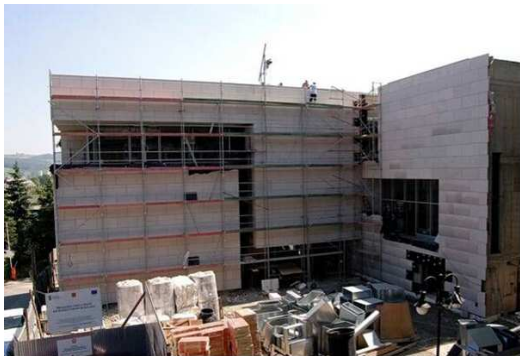
Budowa Małopolskiej Galerii Sztuki „Na Bursztynowym Szlaku”
