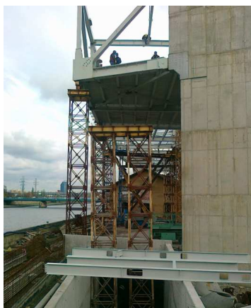
Prace budowlane przy Muzeum Tadeusza Kantora
