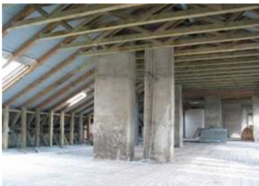
Poddasze Wojewódzkiej Biblioteki Publicznej w Krakowie w trakcie remontu
