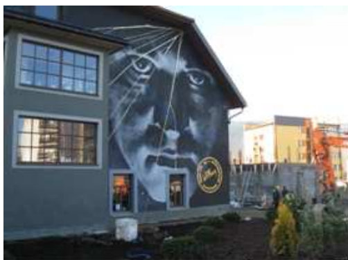
Budynek główny teatru
