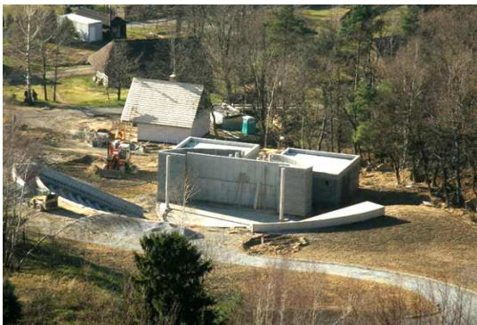
Amfiteatr w budowie
