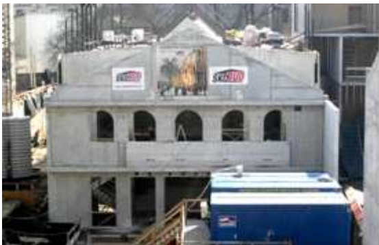
Budowa Małopolskiego Ogrodu Sztuki
