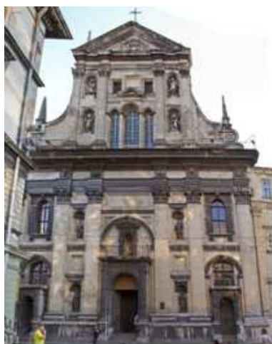
Kościół pw. św.św. Piotra i Pawła we Lwowie- widok z zewnątrz
