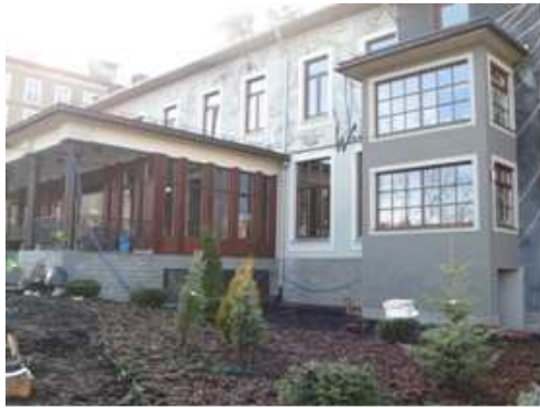
Budynek główny teatru
