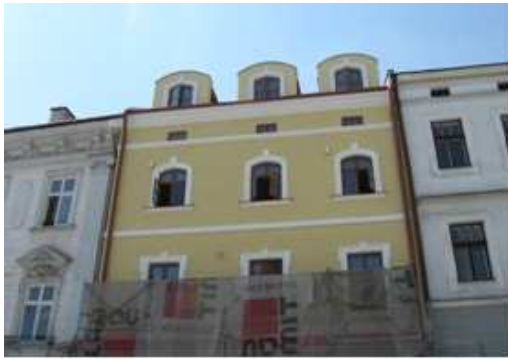
Elewacja kamienicy Rynek 3
