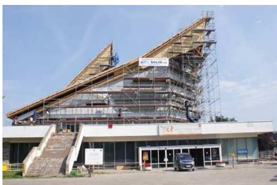
Mościckie Centrum Kultury podczas remontu
