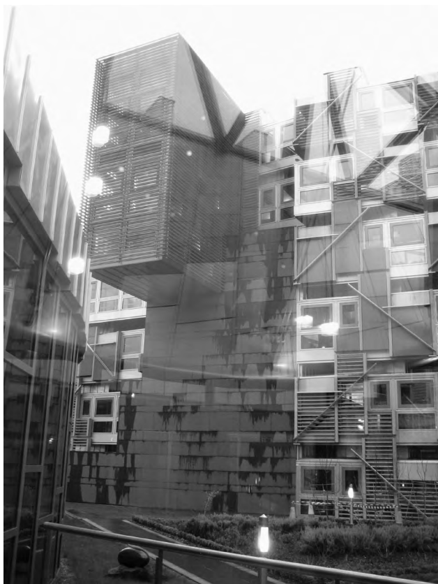
Edynburg przeprowadził wiele udanych projektów rewitalizacyjnych. Fot. Jacek Woźniak
