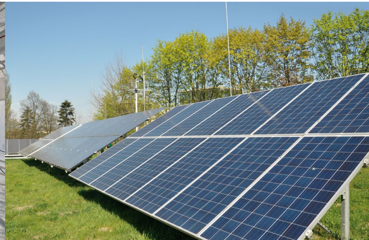
System fotowoltaiczny składający się z paneli: polikrystalicznych, monokrystalicznych (techn. krzemowa) i CIGS (techn. bezkrzemowa). Stanowią źródło zasilania w en. elektryczną laboratoryjnego tunelu doświadczalnego.
