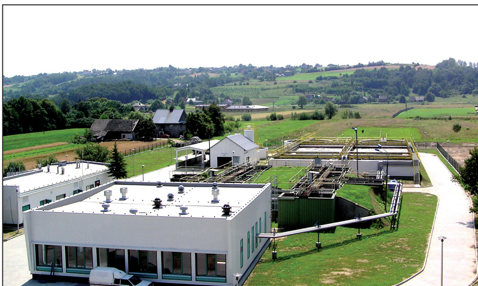
Oczyszczalnia ścieków - Dobczyce
