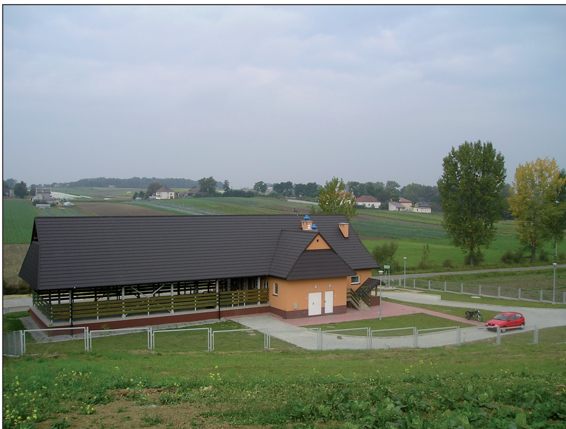
Oczyszczalnia ścieków – Karwin, Gmina Koniusza
