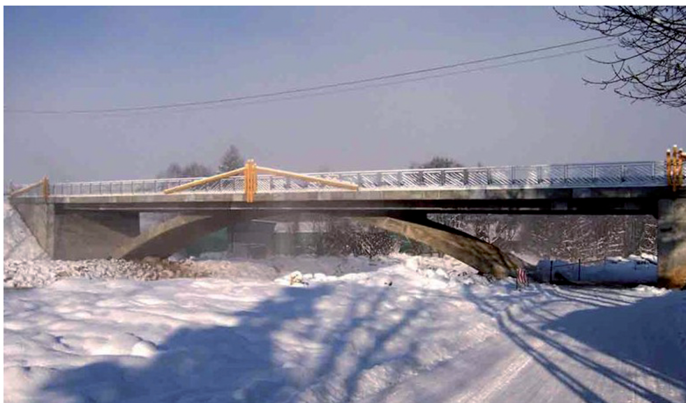
Przebudowa odcinków dróg wojewódzkich 959 i 959 Zakopane – Chochółów – granica państwa – most w Chochółowie
