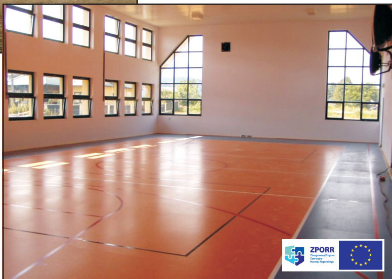
Dobudowa sali gimnastycznej do budynku Szkoły Podstawowej i Gimnazjum w Gołkowicach
