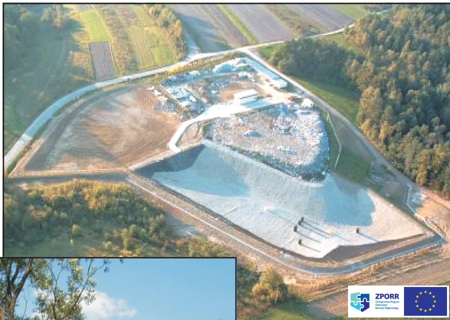
Rozbudowa składowiska odpadów komunalnych w Sułkowicach
