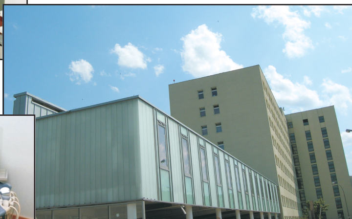
Modernizacja szpitala w Tarnobrzegu
