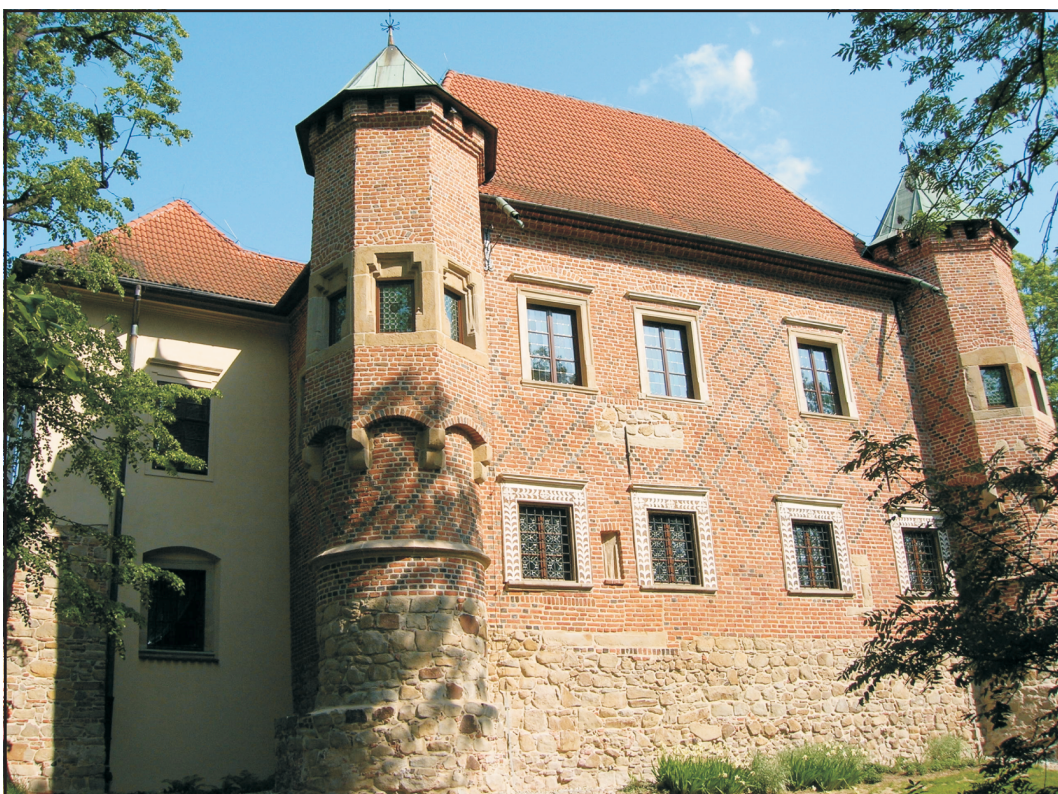
Restauracja i konserwacja elewacji na zamku w Dębnie
