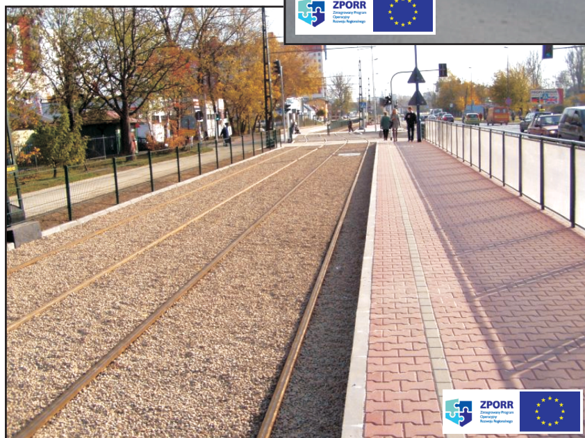
Przebudowa ciągu tramwajowo-autobusowego w ulicach Monte Cassino – Kapelanka – Brożka
