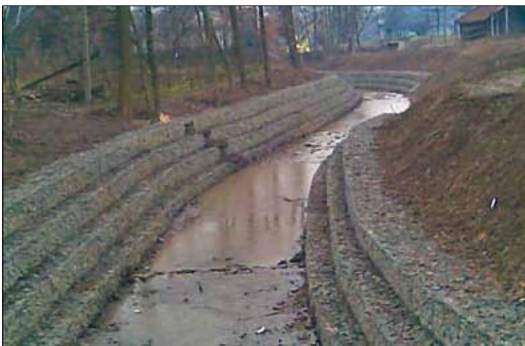
Usuwanie szkód powodziowych na potoku Jasieniczanka
