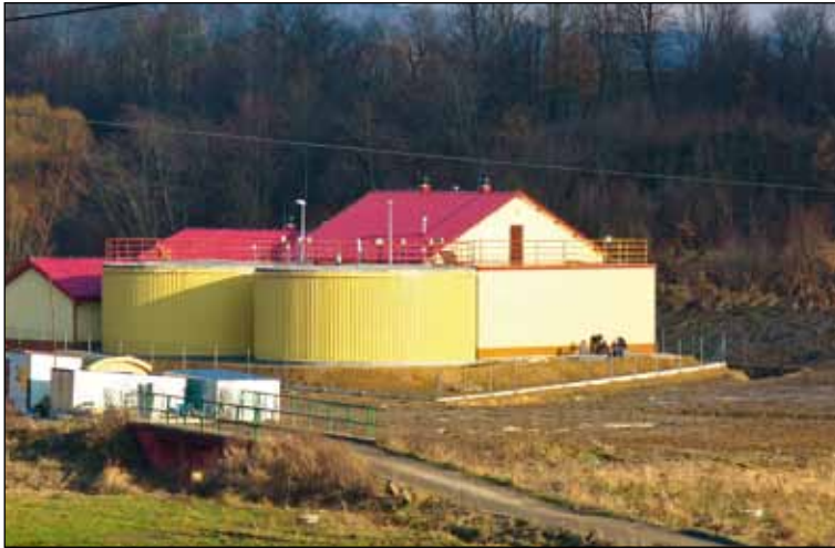
Budowa oczyszczalni ścieków w Szerynach
