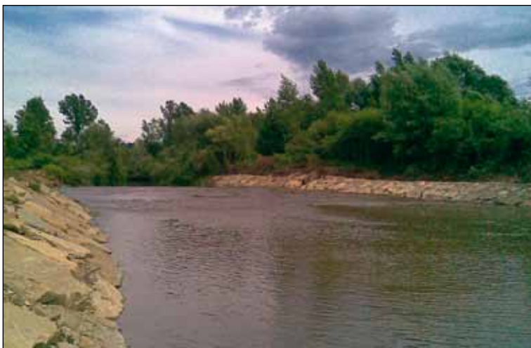
Usuwanie szkód powodziowych na rzece Stradomka
