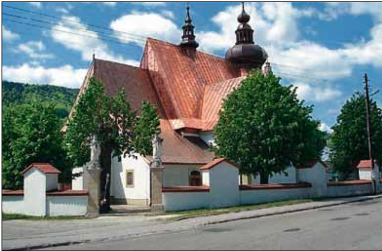
Remont dachu w kościele pw. św. Michała Archanioła w Ujanowicach
