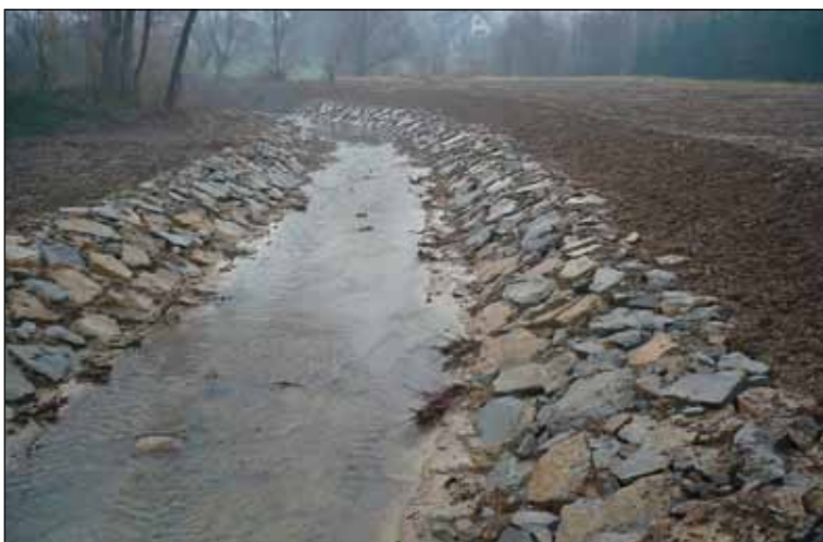
Usuwanie szkód powodziowych na potoku Cedron
