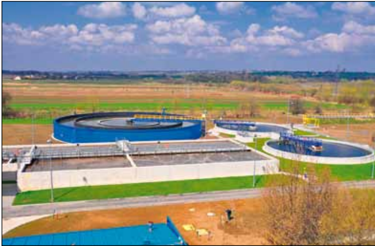
Budowa oczyszczalni ścieków w Wadowicach
