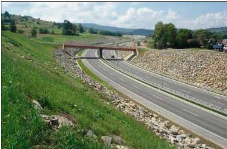
Budowa drogi ekspresowej S-7 – obwodnica Lubnia
