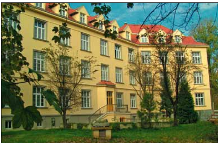
Remont budynku Wojewódzkiego Ośrodka Terapii Uzależnień i Współuzależnienia w Krakowie
