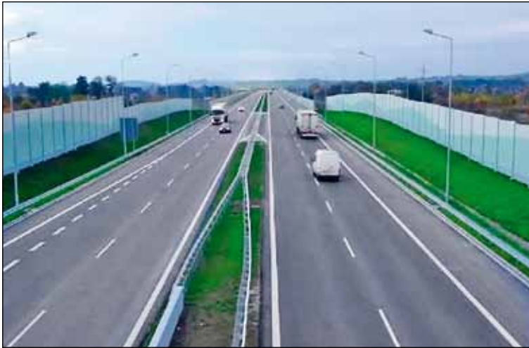
Budowa autostrady A-4 – odcinek Wieliczka–Szarów
