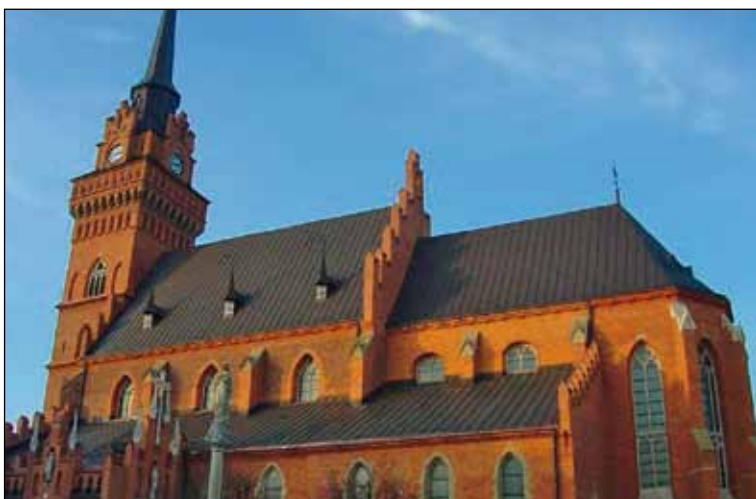
Prace remontowe w Bazylice Katedralnej w Tarnowie
