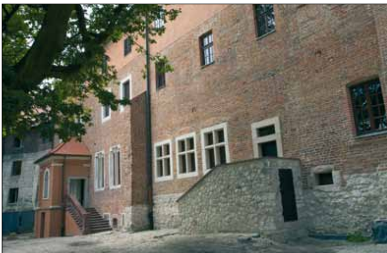
Zamek Królewski na Wawelu – remont konserwatorski budynku nr 7 fot. Stanisław Michta
