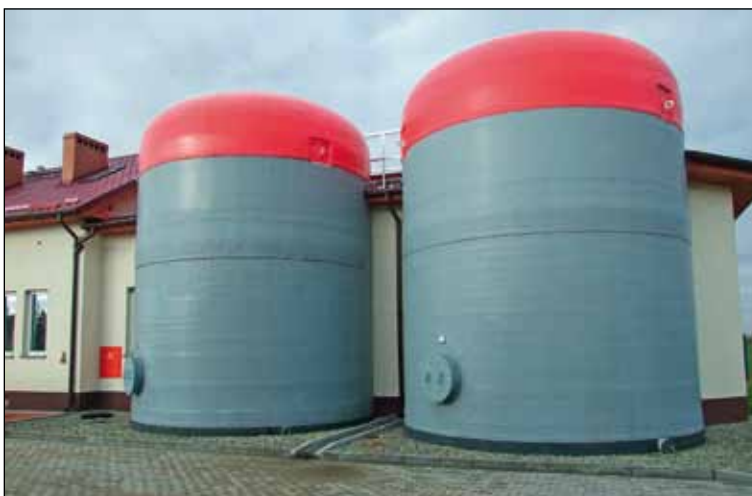
Budowa oczyszczalni ścieków w Woli Zabierzowskiej
