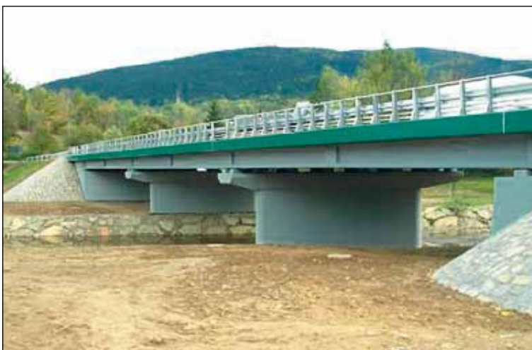
Budowa mostu w m. Dobra na rzece Łososina
