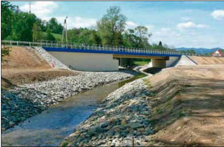
Budowa mostu w m. Malejowa na potoku Naprawka
