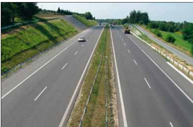
Przebudowa i wzmocnienie obwodnicy Tarnowa
