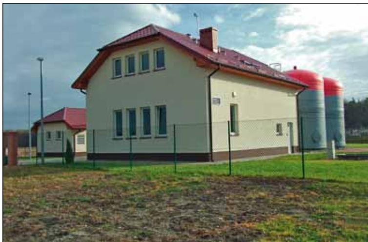
Budowa oczyszczalni ścieków w Zabierzowie Bocheńskim
