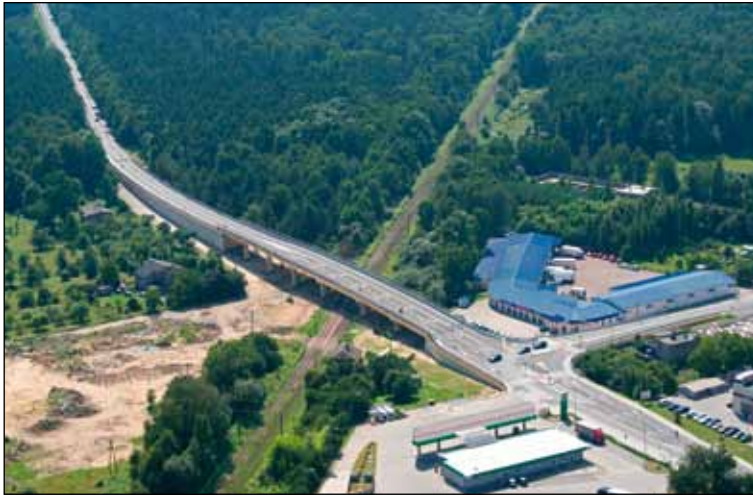
Modernizacja drogi woj. nr 933 na odcinku Brzeszcze – Chrzanów wraz z budową wiaduktu w m. Kroczykach
