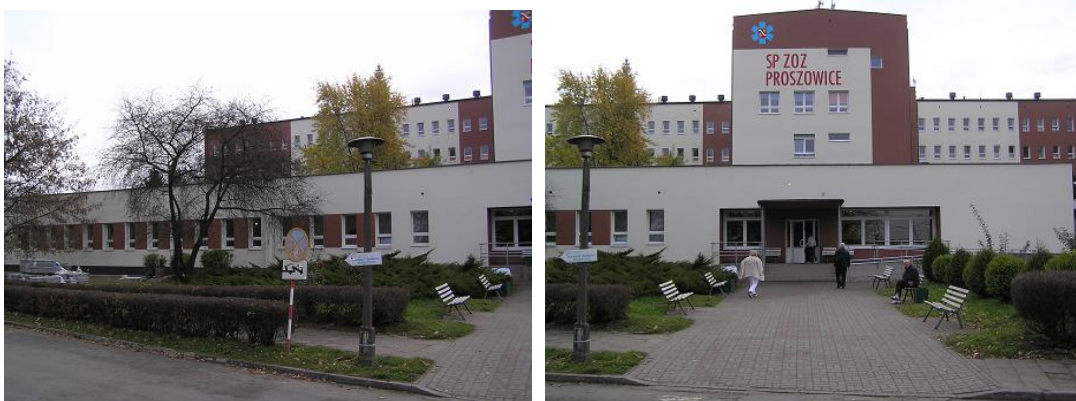
Fot. Budynek główny po termomodernizacji.
